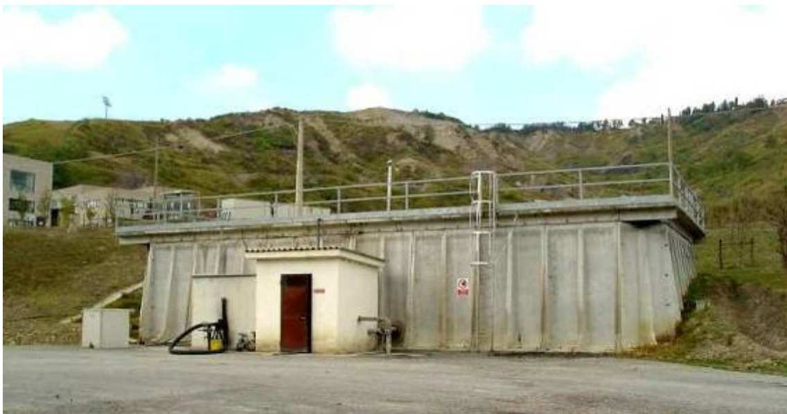
Fig. 13 – La vasca di raccolta del percolato.
