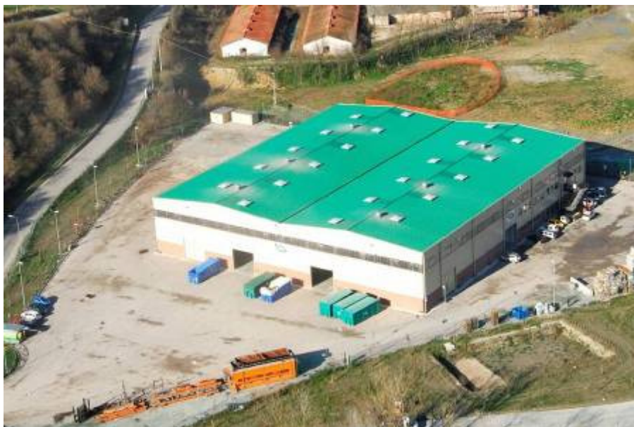
Fig. 2 - Impianto cernita e valorizzazione - veduta aerea.
